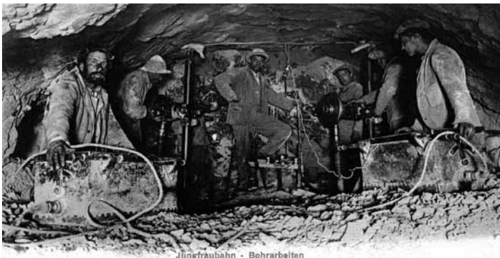
Die Bohrarbeiten beim Bau der Jungfraubahn um ca. 1910 erforderten noch sehr viel mehr Handarbeit.
